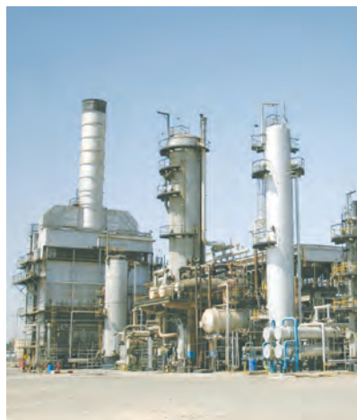
ب) نمای بیرونی برج تقطیر در پالایشگاه
