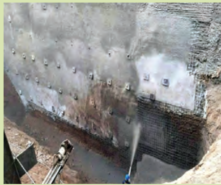
پایدارسازی شیب به روش میخ کوبی
