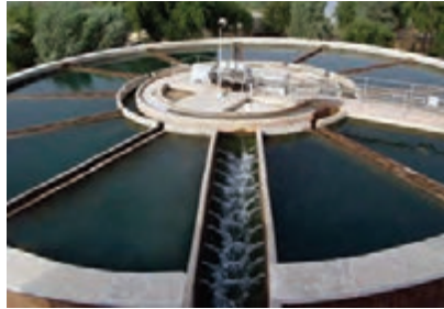
آب در تصفیه‌خانه
