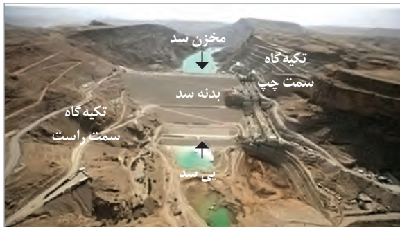
شکل ۴-۵- نمایی از بخش‌های مختلف یک سد
