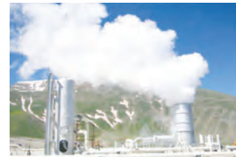
شکل ۱۰- نیروگاه زمین‌گرمایی مشکین شهر که با توان تولیدی ۱۰۰ مگاوات نصب شده است.
